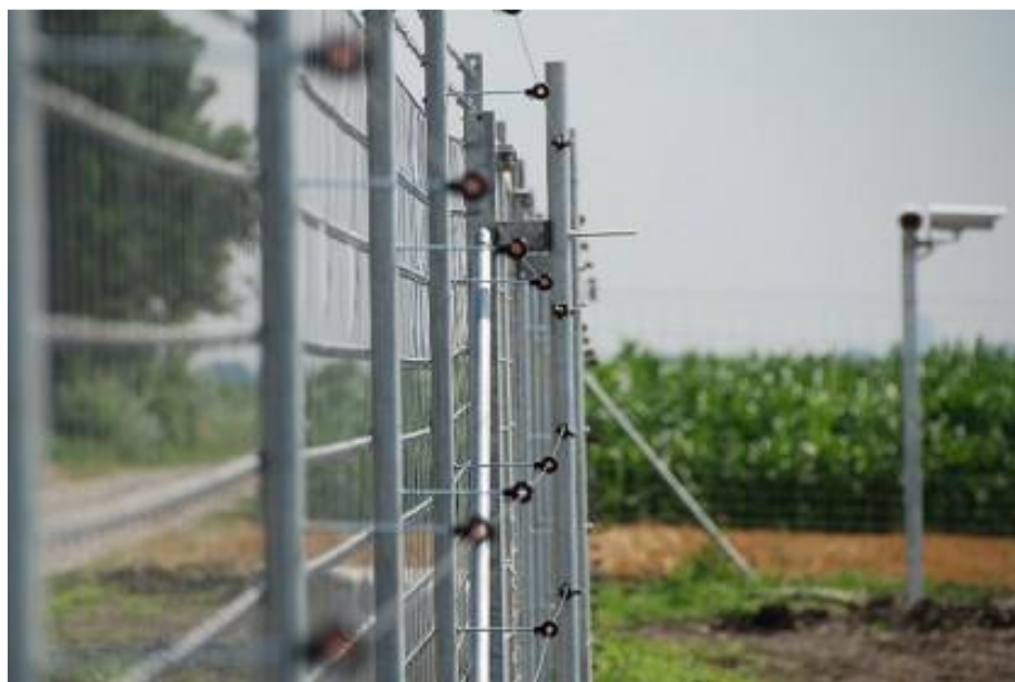
Rysunek 3. Przykładowe ogrodzenie farmy fotowoltaicznej.
