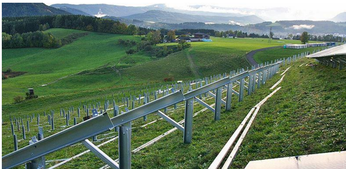
Zdjęcie 3. Konstrukcja przeznaczona do posadowienia paneli fotowoltaicznych.
