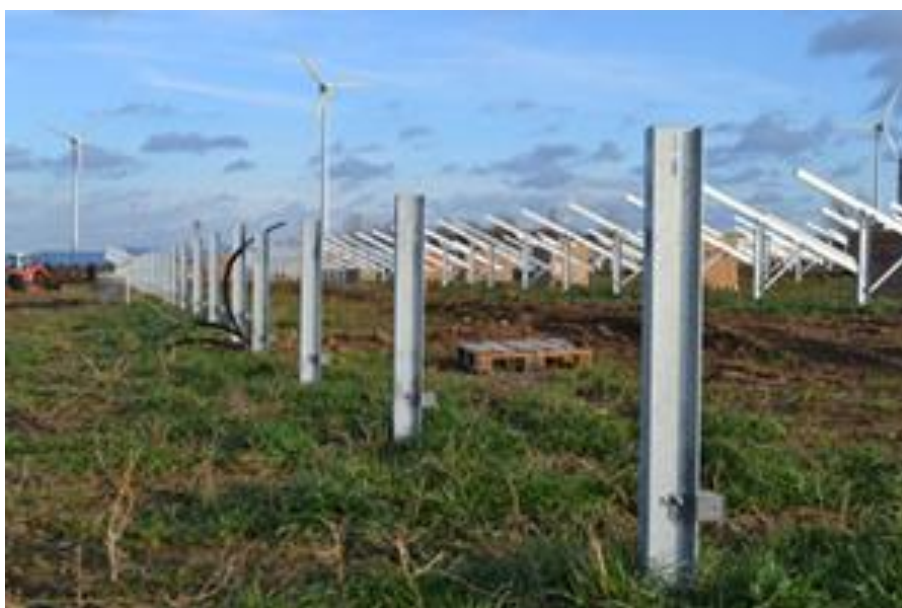
Zdjęcie 1. Profile metalowe: podstawowy element konstrukcji.
