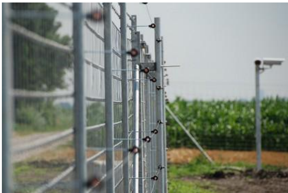
Rysunek 3. Przykładowe ogrodzenie farmy fotowoltaicznej.
