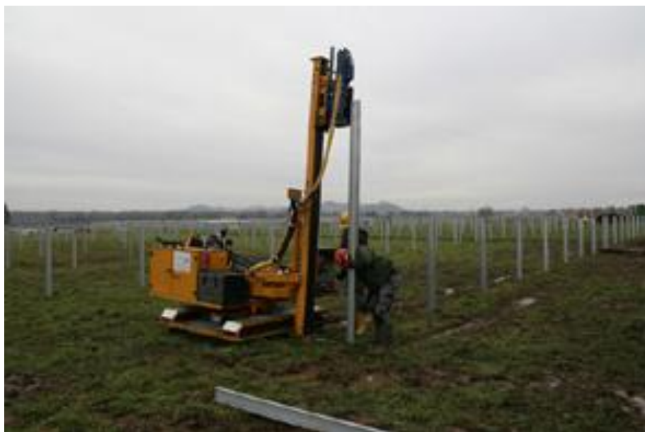
Zdjęcie 2. Montaż profili za pomocą kafara.
