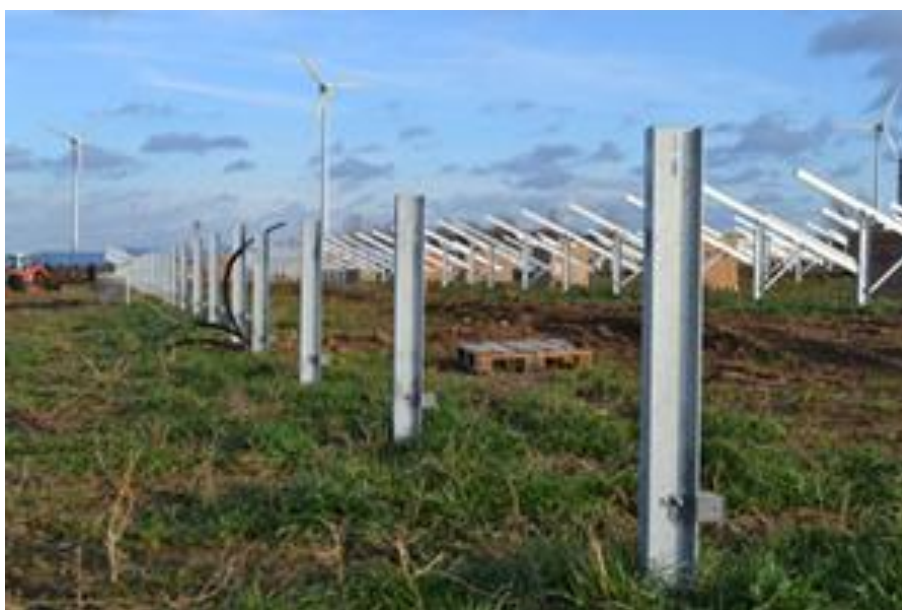
Zdjęcie 1. Profile metalowe: podstawowy element konstrukcji.
