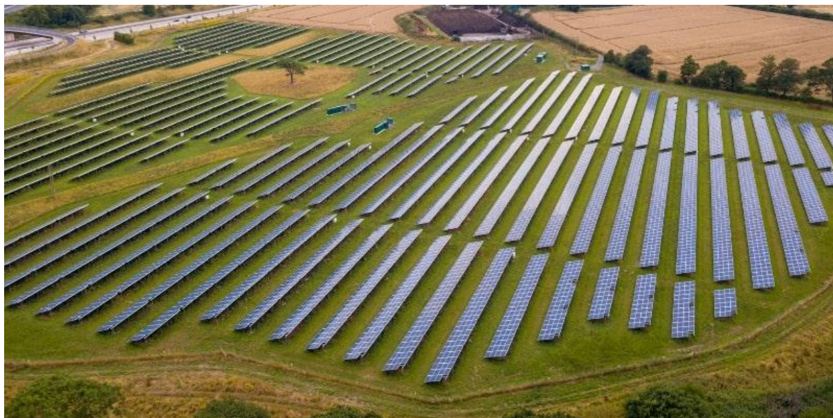
Rysunek 7. Widok elektrowni fotowoltaicznej [5]
