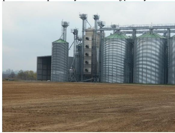
Teren działki nr 303/2 oraz widok istniejących silosów
