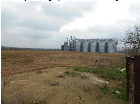
Teren działki nr 303/2 oraz widok istniejących silosów
