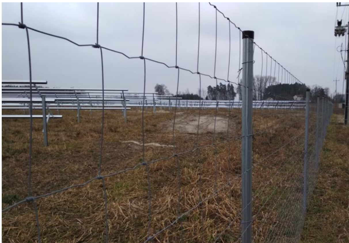
FOTOGRAFIA 3. Widok na przykładowe ogrodzenie dla instalacji, o ustalonej szerokości oczek w siatce [foto: Paweł Kręciproch; instalacja w miejscowości Poddębice]
