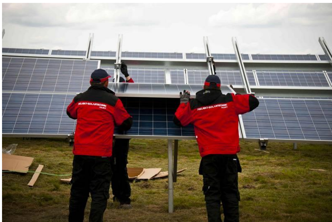
FOTOGRAFIA 9. Przykładowy montaż paneli na konstrukcji nośnej
