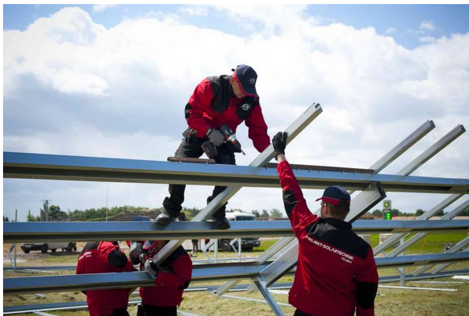
FOTOGRAFIA 7. Przykładowy montaż konstrukcji
