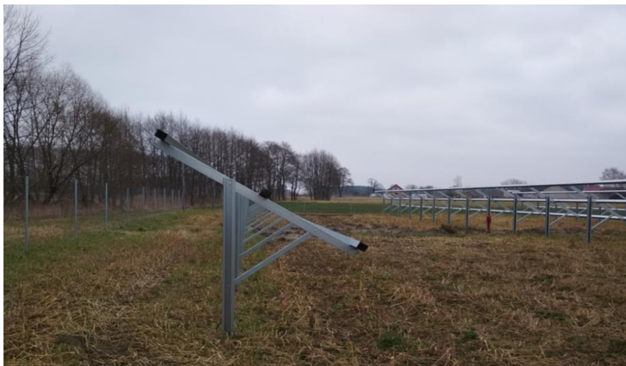
FOTOGRAFIA 1. Konstrukcje wsporcze przygotowane do montażu paneli fotowoltaicznych – widoczne kilkumetrowe odstępy między rzędami, [foto: Paweł Kręciproch; instalacja w miejscowości Poddębice]
