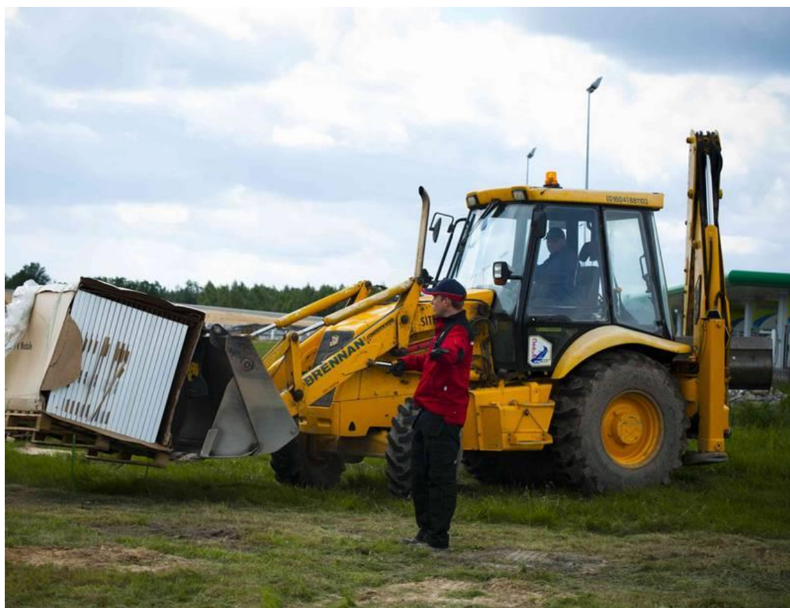
FOTOGRAFIA 8. Dowóz paneli do montażu
