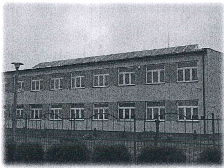
Ryc.2. Instalacja fotowoltaiczna na budynku Zespołu Szkół w Zbójnie.
